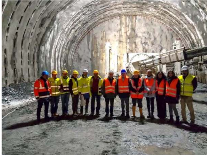
Ripresa dei Lavori di Scavo – 07/01/2019
