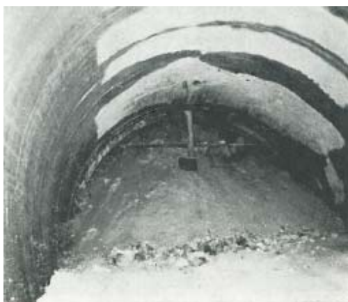
Figura 2: Rilascio dolomia farinosa - estratto da "geologia e idrogeologia del territorio interessato dalla G F Santa Lucia..." (A. Macchi)
