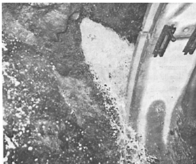
Figura 5: Venite d'acqua nella galleria Santa Lucia - estratto da "geologia e idrogeologia del territorio interessato dalla G F Santa Lucia..." (A. Macchi)
