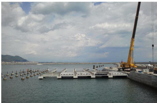
Sistema di accosto ed ormeggio per l'attracco di navi Ro-Ro e Ro/Pax al Molo di Ponente – Lavori in itinere
